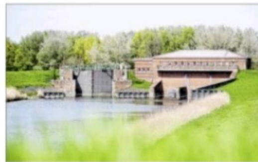
Die Kapazität von Schöpfwerken muss erhöht und mehr Flächen zur Speicherung von Wasser gefunden werden. Das Foto zeigt das Schöpfwerk in Emden-Borssum.
