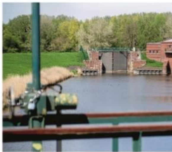
Die Kapazität von Schöpfwerken, hier das Werk in Borssum in Emden, mehr Flächen zur Speicherung von Wasser gefunden werden.
