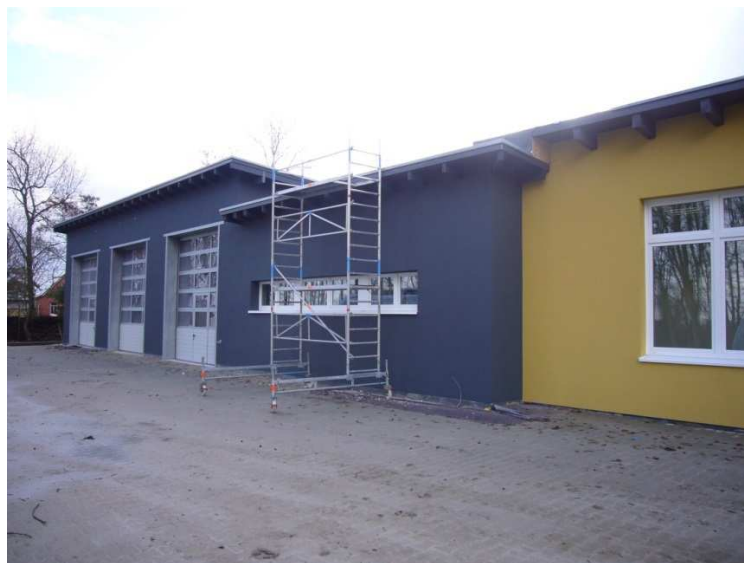
Neubau der Rettungswache als Anbau an das ehem. Werkraumgebäude – Fertigstellung Dezember 2014
