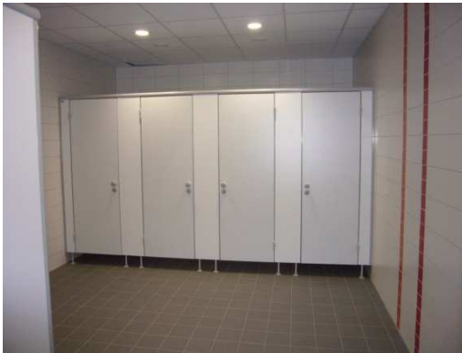
Renovierte Toilettenanlage Gebäude 4
