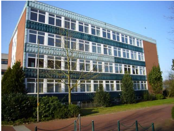
Gebäude 1 (Klassentrakt) – hier ist eine Kernsanierung vorgesehen.
