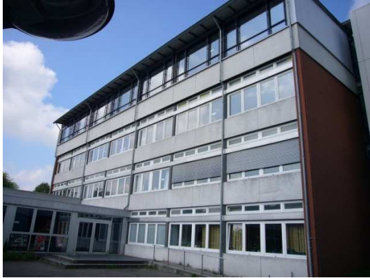
Gebäude D - Hauptgebäude – Fenstererneuerung 2015 und 2016 vorgesehen.
