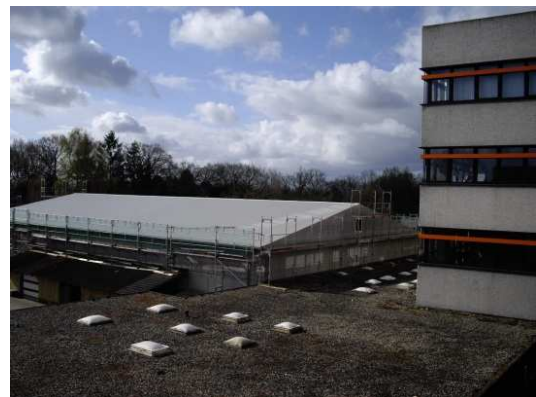
Gebäude 3 – Bauhalle (Holzbau - Tischler). Dach 2010 saniert (Blechdach), kein Handlungsbedarf
