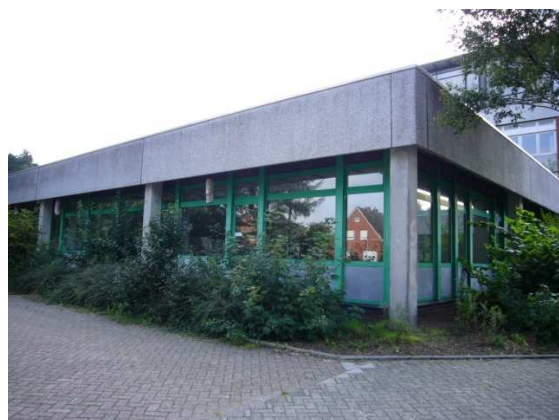
Gebäude B - Naturw. Gebäude – hier ist dessen Abbruch und die Erstellung eines Neubaus geplant.
