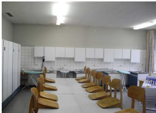
Innenansicht eines Hauswirtschaftsraumes vor der Sanierung Gebäude 9
