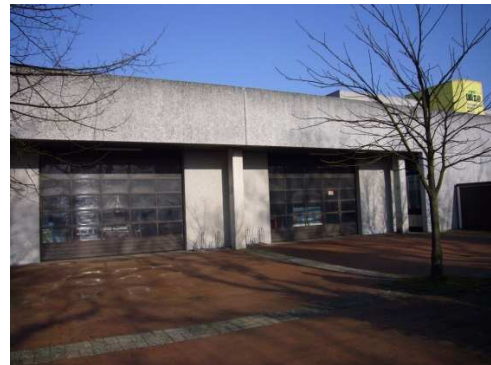
Gebäude 7 – Kfz und Metallbereich
