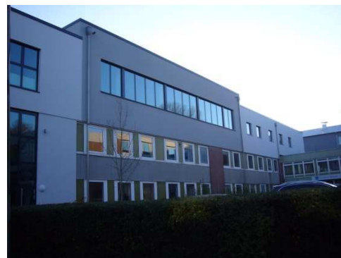
Gebäude 4 – Außenansicht mit Aufstockung
