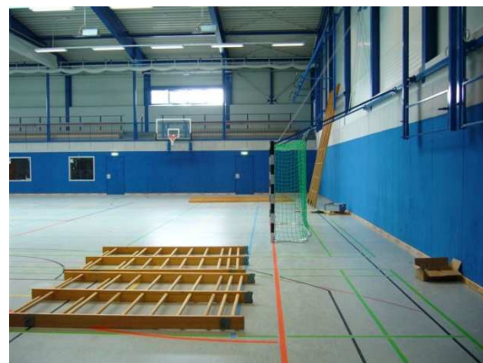
Innenansicht Sporthalle mit neuer Tribünenanlage
