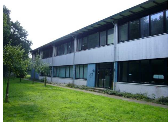
Gebäude 1 (A) –Mensagebäude. Kein Handlungsbedarf.
