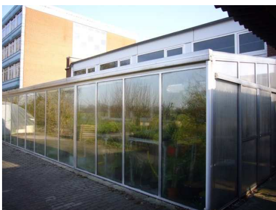
Gebäude 8 – Gartenhalle mit vorgelagertem Gewächshaus. Komplett renoviert Herbst 2014, mit Ausnahme Fußboden – Ausführung Osterferien 2015.
