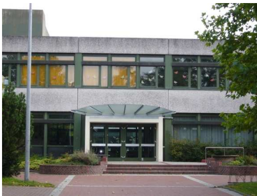
Ansicht Haupteingang Förderschule LH
