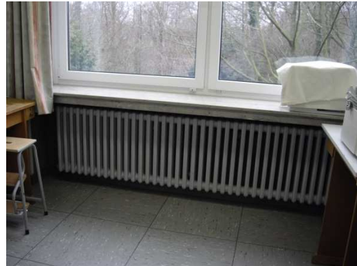
Innenansicht eines Klassenraumes Gebäude 9
