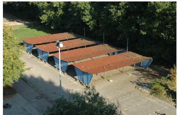
Diese Fahrradständer sollten in absehbarer Zeit erneuert und evtl. erweitert werden.
