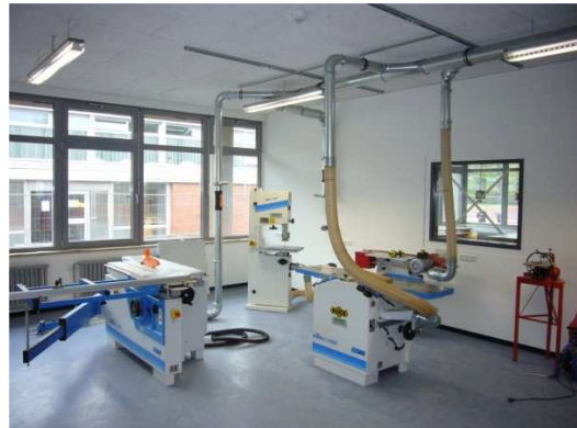
Renovierter Maschinenraumim Werkbereich GebäudeE
