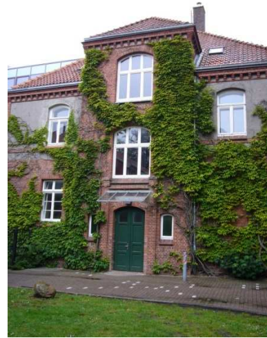
Ehemaliges Kreishaus I- Gebäude D
