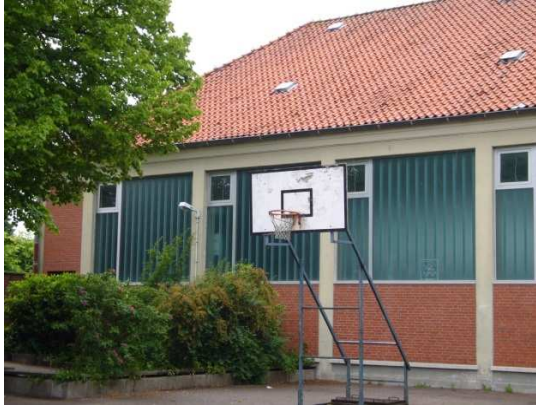
Turnhalle Am Spiet – Gebäude F, hier ist die Sanierung der Umkleiden und Duschen erforderlich.
