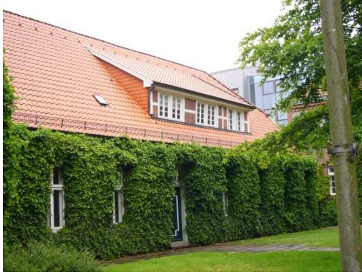
Ehemaliges Kreishaus III – Gebäude E - Kunstabereich des Gymnasiums. Die Fenster müssen erneuert werden.
