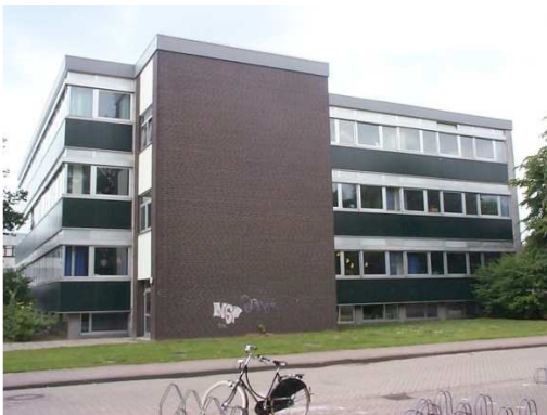
Gebäude 1, Jahrgänge 5 und 6. Kernsanierung erforderlich.
