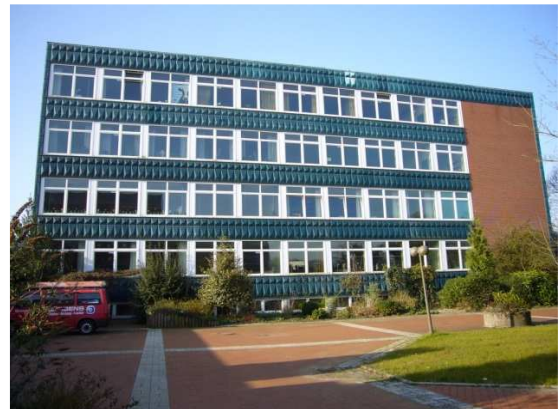
Gebäude 9 – hier ist eine Kernsanierung vorgesehen.
