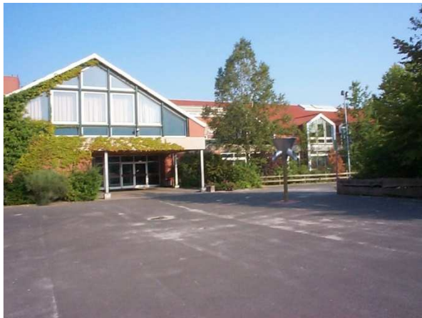
Ansicht Schulhof mit Eingang
