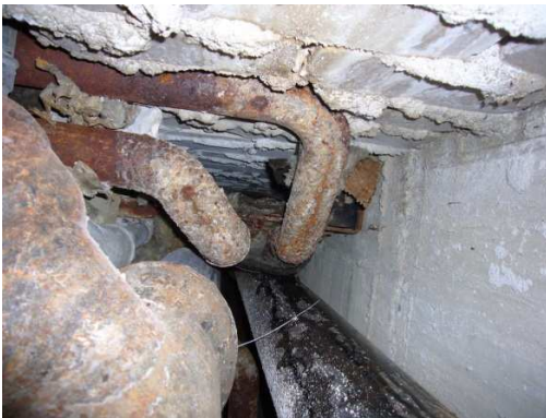
Blick in einen Versorgungsschacht in Gebäude 1
