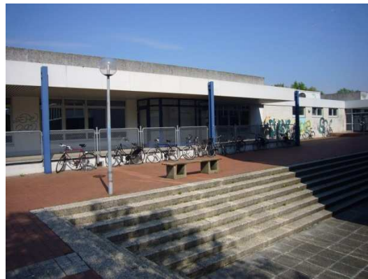
Gebäude 2, AWT- Bereich
