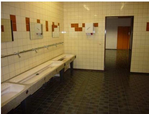
Gebäude 1 - Vorraum Toilettenanlage Keller Hauptgebäude
