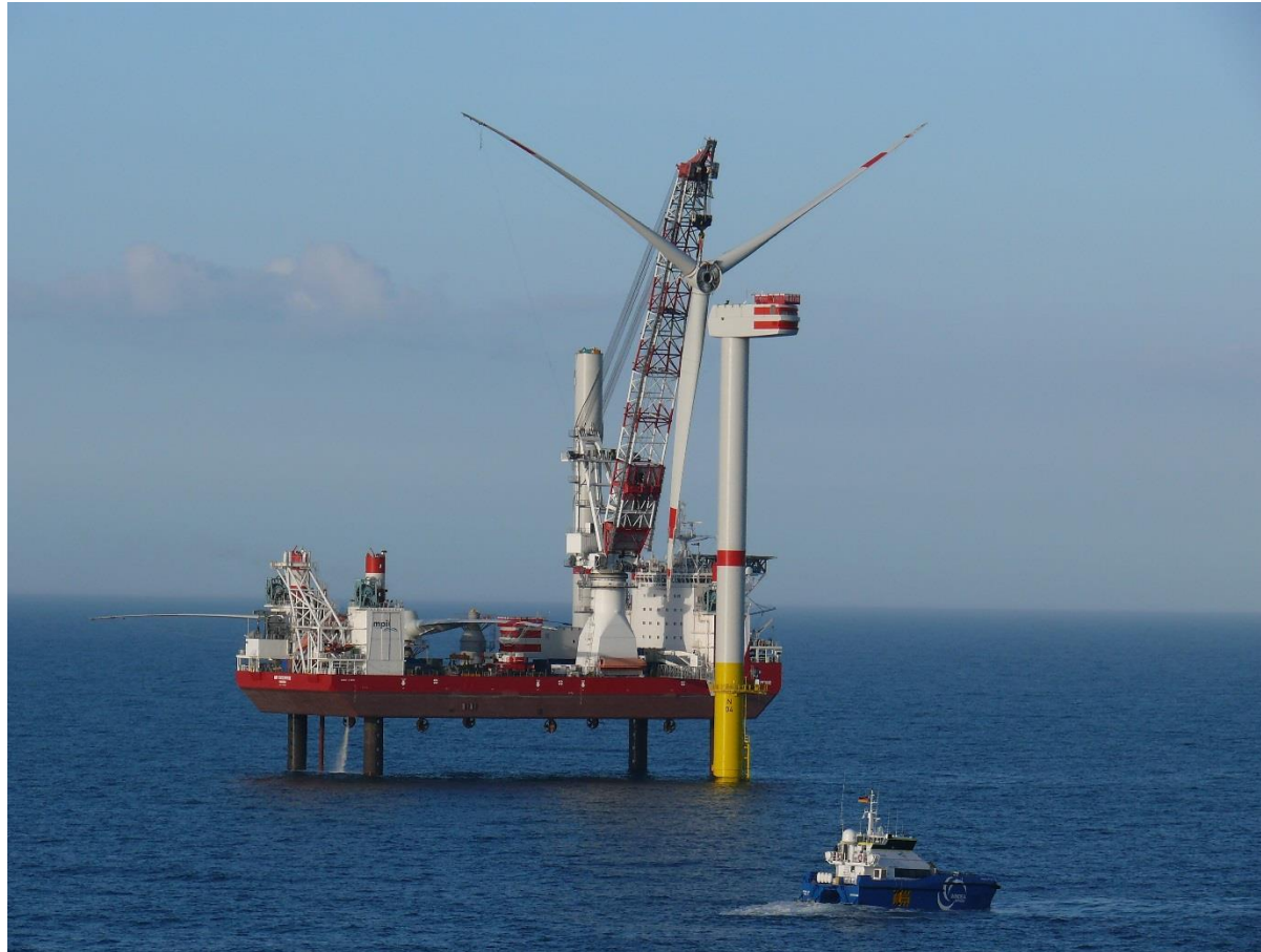
Errichtung einer Windenergieanlage im Windpark Nordsee One. Quelle: Nordsee One
