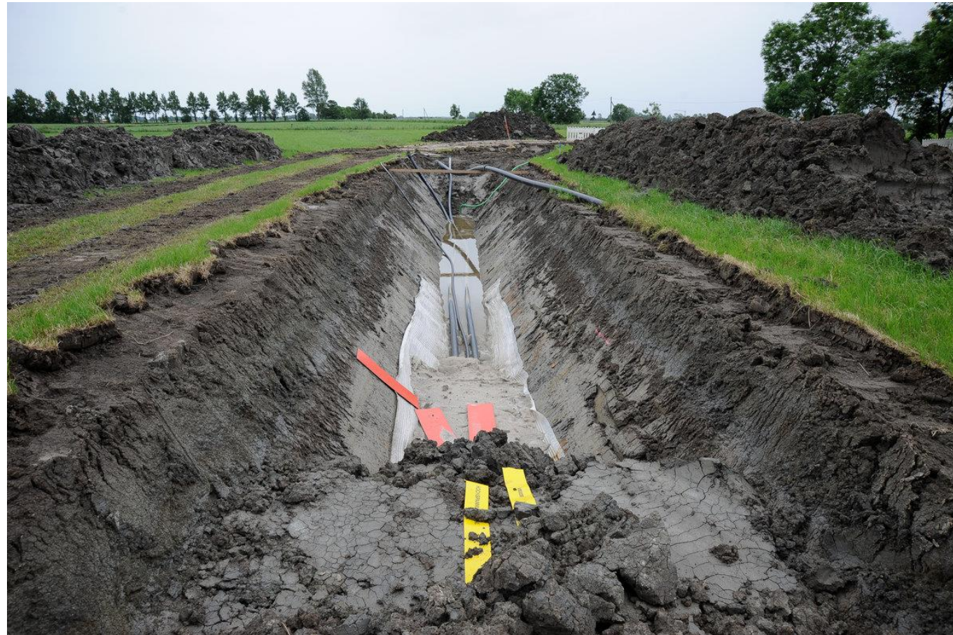
Kabelverlegung an Land durch Tennet, hier bei Loppersum.
